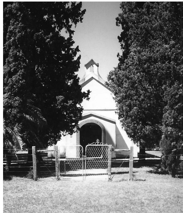
Foto reciente de la Iglesia Interdenominacional de Mandisovi consagrada en año 1898. Construido por los Evangelicos de la zona
